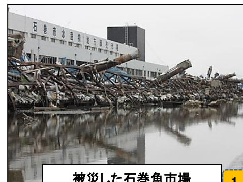
被災した石巻魚市場
