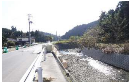
大型土のうにより応急復旧完了
