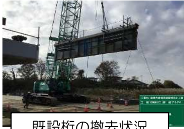
既設桁の撤去状況
