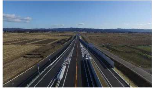
平成29年度地道改復興3-A02号 みやぎ県北高速幹線道路（中田工区） 舗装（その2）工事 登米市中田町宝江地内
