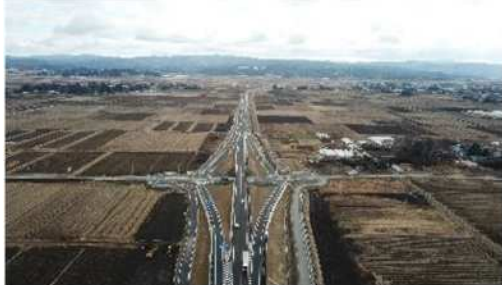
平成29年度県債地道改復興3-A04号 みやぎ県北高速幹線道路（中田工区） 舗装（その3）工事 登米市中田町宝江地内外
