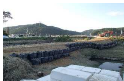
大型土のうにより応急復旧完了
