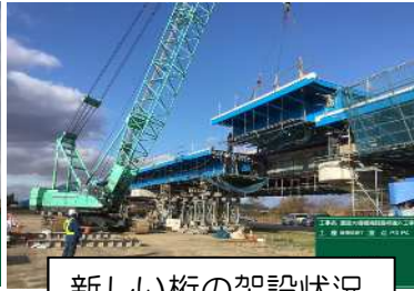
新しい桁の架設状況
