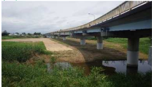
平成28年度県債社道復興橋補12-103-A01号 豊里大橋橋梁耐震補強工事 登米市豊里町川前地内
