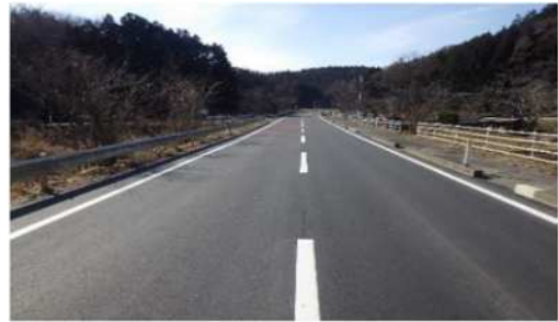
平成29年度県舗補〇5008-A02号 米谷外舗装補修工事（その2） 登米市東和町米谷地内外
