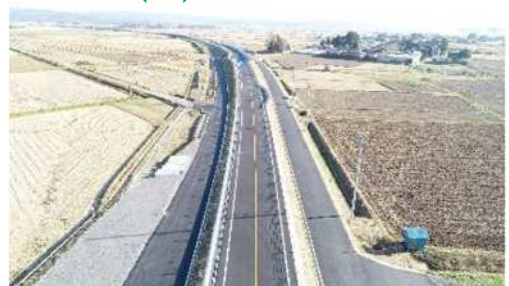
平成29年度地道改復興3-A01号 みやぎ県北高速幹線道路（中田工区） 舗装（その1）工事 登米市中田町宝江地内外
