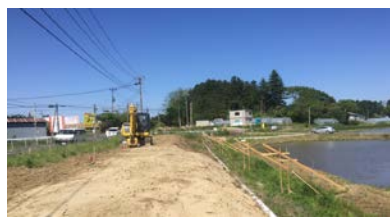
板倉歩道設置工事（H29.5現在）
