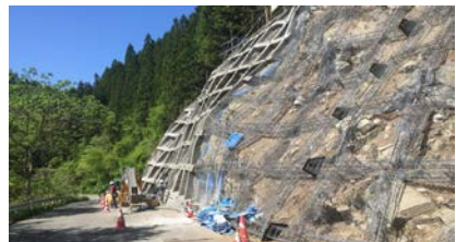
上羽沢災害防除工事（H29.5現在）
