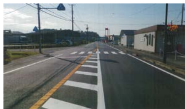
舗装補修工事（H29.3）
