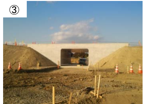
③ 10号函渠の施工状況
