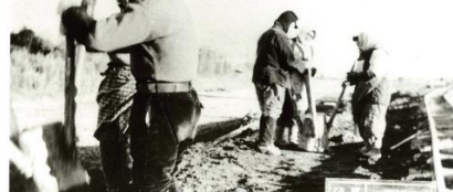
搗固(つきかため)工の施工状況
