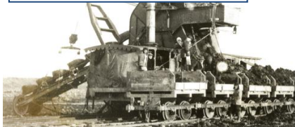
ソントランダーエクスカーによる掘削積込状況
