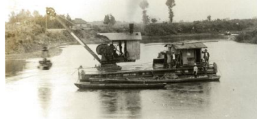
ブリストマンバケット浚渫船
