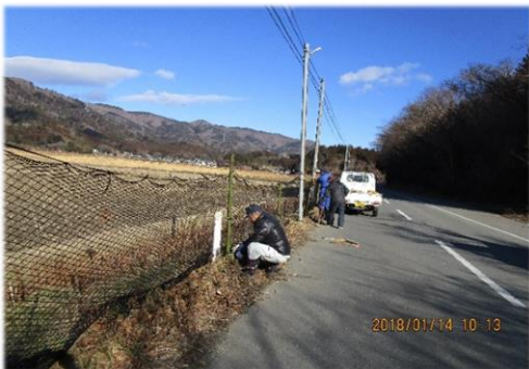
車両衝突事故回避のための緊急防鹿柵（網）の設置
