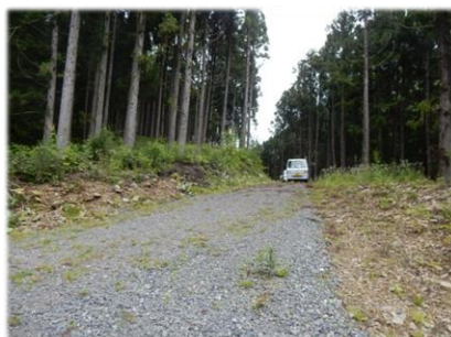
軽トラック等の車両が通行可能な作業道
