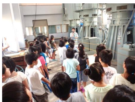
▲中山揚水機場内を見学 (須江小学校5年生)
