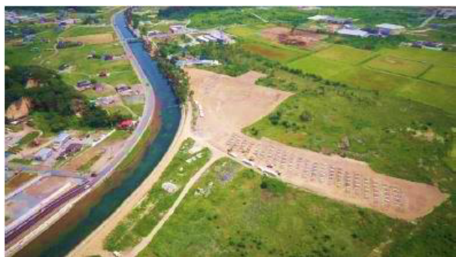
▲太陽光施設造成予定地
