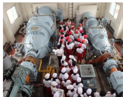
▲曾波神排水機場内 (須江小学校5年生)
