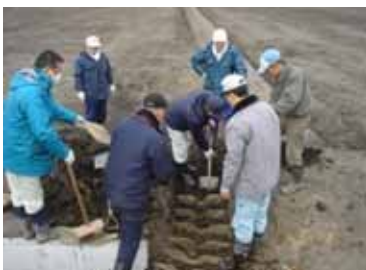
魚道設置作業の様子
