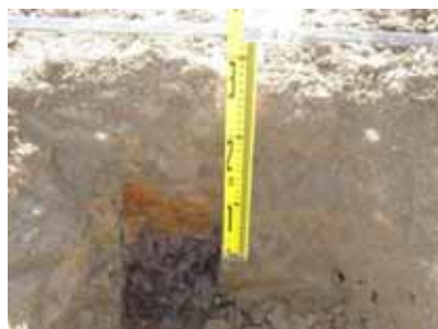
疎水材上端の沈下量調査
