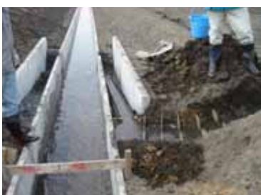
完成した魚道
