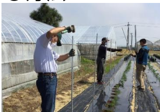
片側の支柱をハンマーなどで打ち込む
