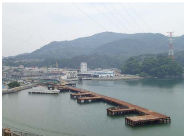
【現場状況（仮設作業構台）】
