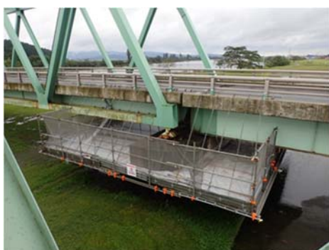
【神取橋耐震補強】
