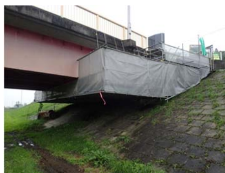
【及川橋耐震補強】
