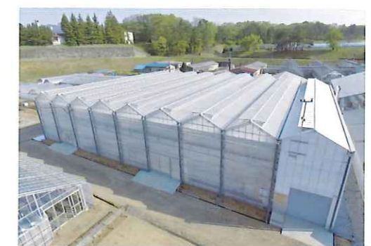
最先端の試験研究施設 軒高6m、最新の環境制御機器を備えた施設
