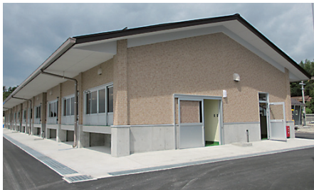
再建したカキ処理施設(東松島市)
