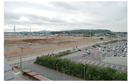
新蛇田地区造成工事の状況(石巻市)
