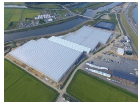
【次世代施設園芸拠点】
