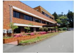
⑧多賀城分庁舎
