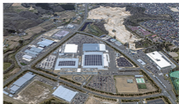
大和リサーチパーク
