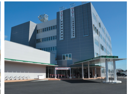
⑧気仙沼合同庁舎の新庁舎（気仙沼市）
