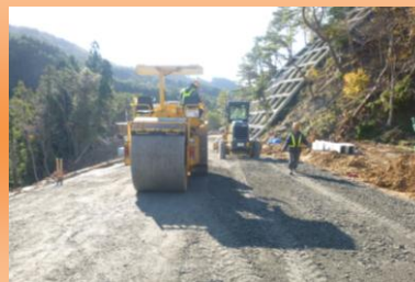
< 復旧工事の状況 >
