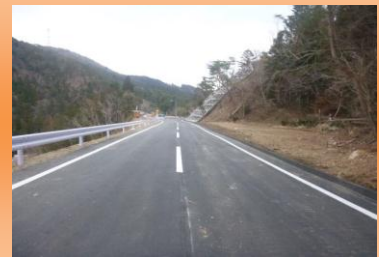
< 災害復旧工事完成 >
