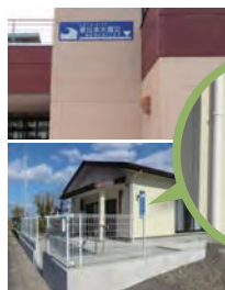
津波浸水表示板
