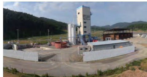
南三陸町戸倉地区の仮設生コンプラント
