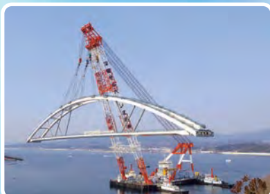
① 大島架橋 気仙沼市 (H29.3架設完了)
