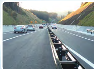
② 三陸縦貫自動車道 (H28.10 三滝道IC～志津川IC開通)
