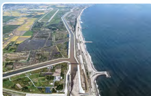
④ 北上運河 東松島市(H28.9完成)
