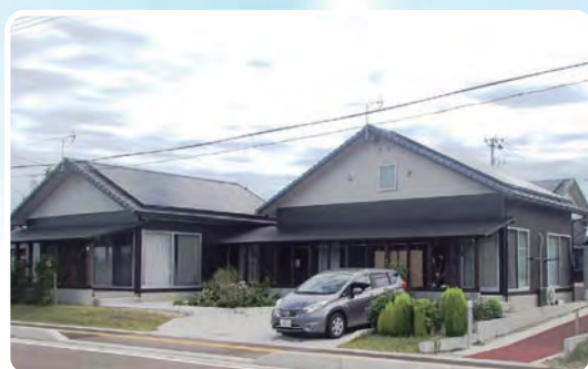
⑦ 災害公営住宅 岩沼市玉浦西地区(H27.3完成)
