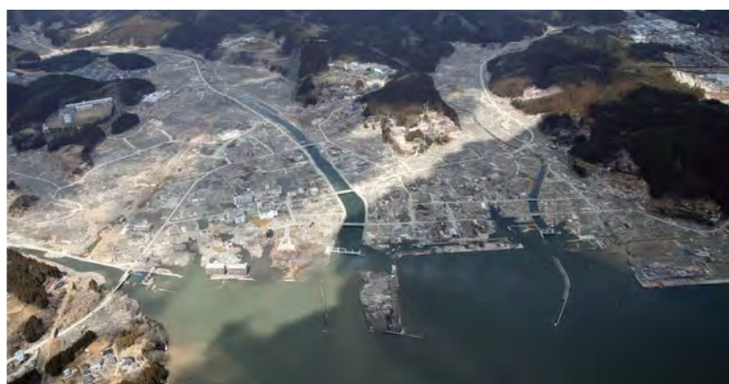
被災直後<平成23年3月撮影>
