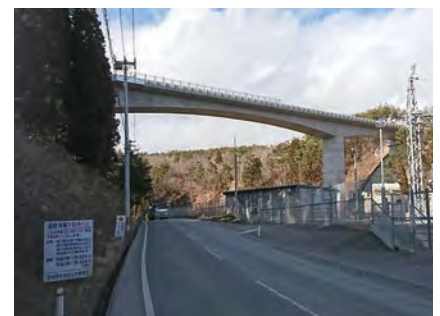
▲志津川IC～南三陸海岸IC間の高架橋
