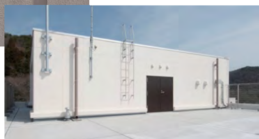
▲ 屋上の一次避難スペースに隣接して防災倉庫を設置
