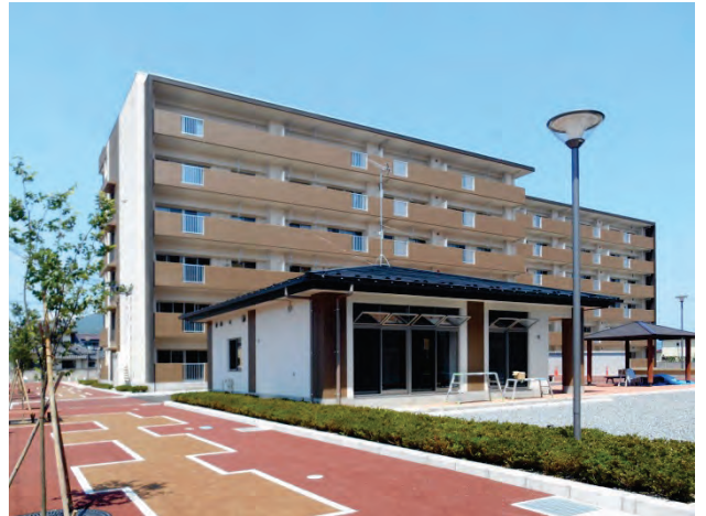
図 2-115 県受託（石巻市黄金浜北地区）
