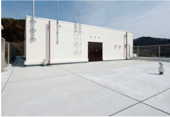
図 2- 125 屋上へ一次避難スペースと隣接し，防災倉庫を設置
