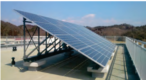
図 2- 130 屋上へ太陽光発電設備を設置
