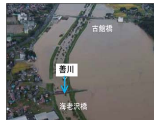
善川(浸水状況)
