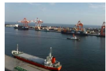
高砂コンテナターミナル (仙台港区)
