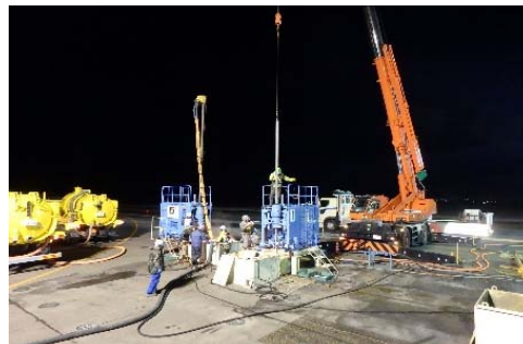
耐震対策工事の施工状況
