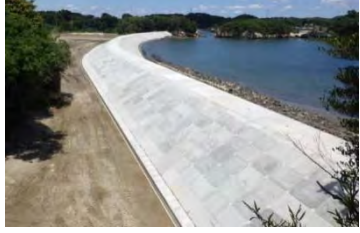
●復旧状況(野々島海岸)
