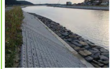
●復旧状況(真野川)
