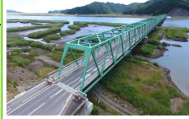
●復旧状況(新北上大橋)
