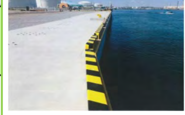
●復旧状況(北航路西C護岸)
