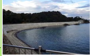
●復旧状況(館浜海岸)
