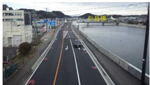
※供用開始後、取付部分の施工等を行ってきました。
