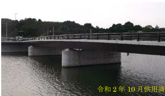
(一) 高城停車場線 松島橋 (松島町)
