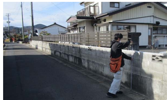
通学路沿いのブロック塀 (点検状況)
