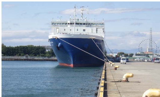
耐震強化岸壁 〔仙台塩釜港（仙台港区）〕
