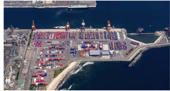
高砂コンテナターミナル拡張整備 〔仙台塩釜港（仙台港区）〕
