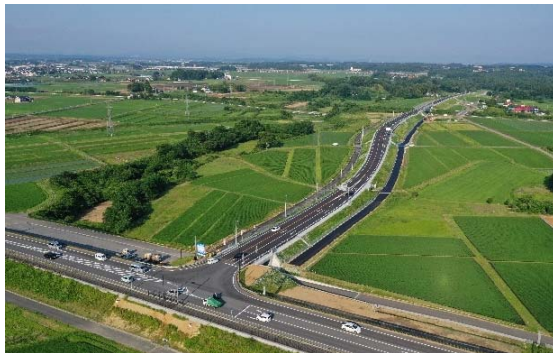
みやぎ県北高速幹線道路
