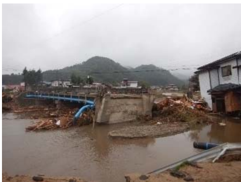
令和元年東日本台風被害 (河川)
