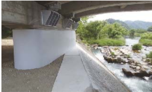
橋梁耐震化（橋脚巻立て）
