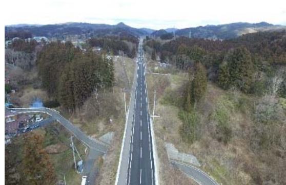
県際・郡界道路整備 〔(国) 346号 錦織バイパス〕
