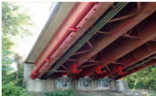
橋梁耐震化（落橋防止）
