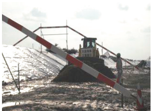
30 大曲海岸災害復旧着工の様子
