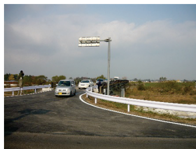
21 通行止め解除直後の志田橋
