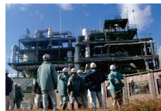
42 仙塩浄化センター汚泥焼却施設の運転実施
