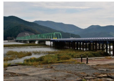
19 新北上大橋仮橋の様子
