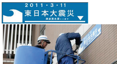
31 津波浸水表示板設置の様子
