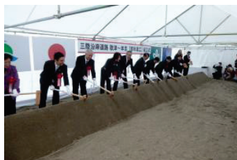
34 着工式の様子
