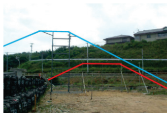
21 計画堤防の丁張設置
