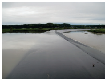
15 品井沼遊水地越流状況 (大崎市鹿島台字下志田地内)
