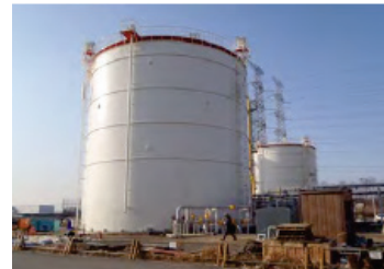
■ 写真 4-3-26：復旧工事状況
