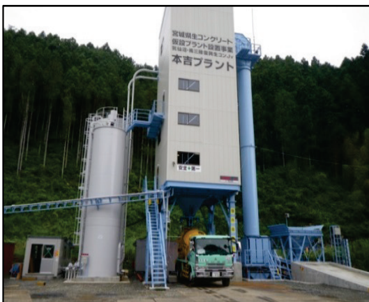
■写真 4-4-1: 気仙沼市本吉地区の仮設プラント
