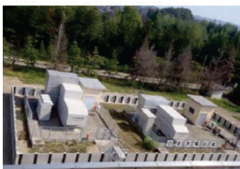
■ 写真 4-3-24：施設復旧及び浸水対策完成
