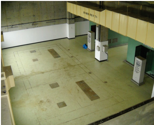
■写真 4-3-28：県南浄化センター 電気設備を2階へ移動
