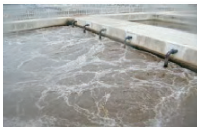
■ 写真 4-3-22：水処理施設復旧後①
