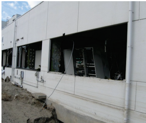
■写真 4-3-27：県南浄化センター 窓閉鎖による耐水化
