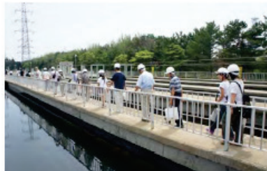
■ 写真 4-3-25：施設見学（水処理施設）
