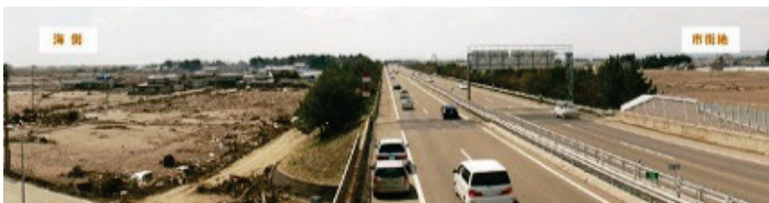
■写真 4-2-15：仙台東部道路による津波被害低減 (国土交通省東北地方整備局ホームページより)
