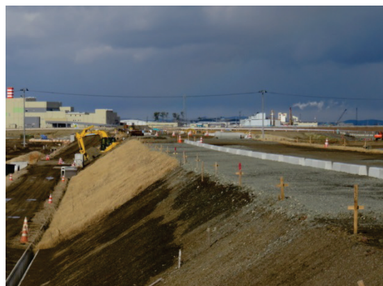
■写真 4-2-18：(市) 空港三軒茶屋線（平成 28 年 2 月）
