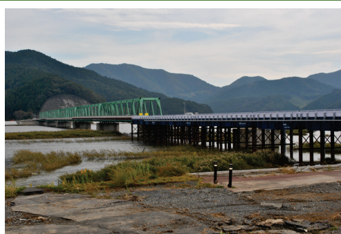
■ 写真 2-1-3：仮橋供用開始 (平成23年10月)
