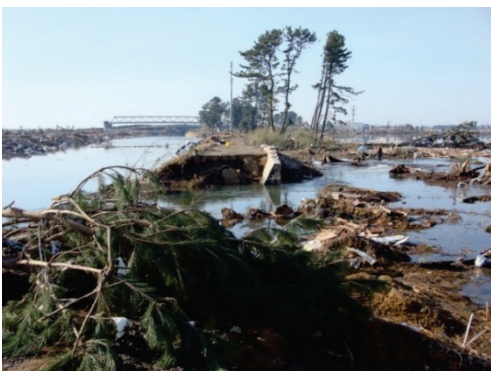
■写真 2-1-6：中貞山運河堤防被災状況（名取市関上）
