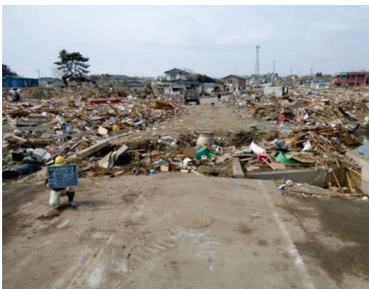
■ 写真 2-1-4：(主) 塩釜七ヶ浜多賀城線橋本橋被災状況 (七ヶ浜町菖蒲田)
