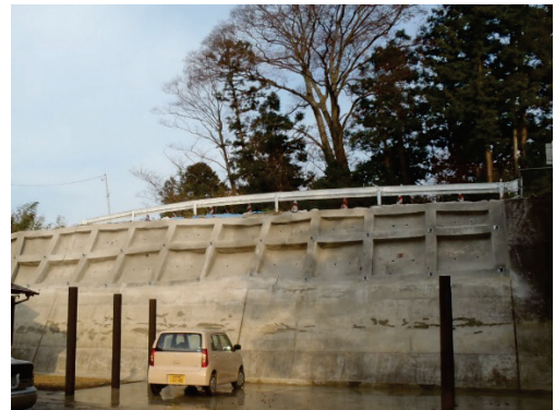
■写真 2-1-11：復旧状況（平成23年12月）
