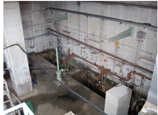
■写真 2-1-13：復旧状況（平成23年7月）
