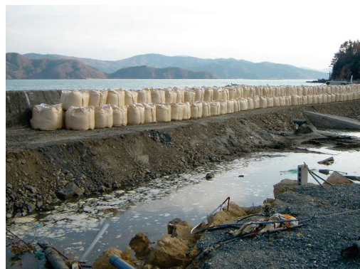
■写真 2-1-9：復旧状況（平成 23 年 8 月）
