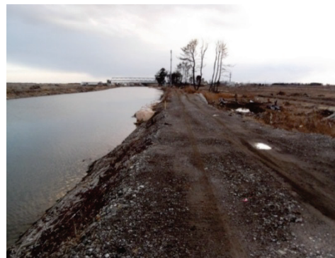
■写真 2-1-7：復旧状況（平成 24 年 2 月）
