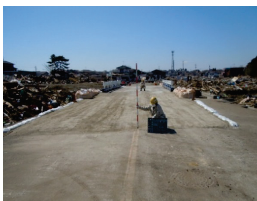
■ 写真 2-1-5：復旧状況 (平成23年3月)
