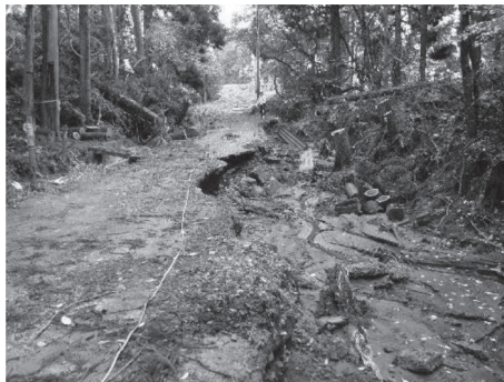
路肩崩壊による通行止め
