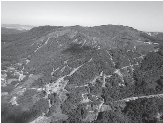
山腹崩壊状況（丸森町子安地区）
