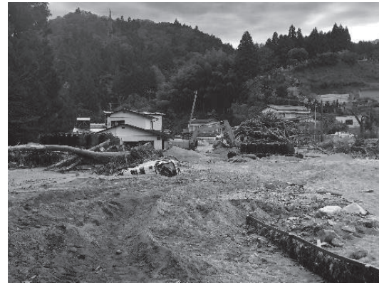
丸森町内の土砂堆積状況（2）
