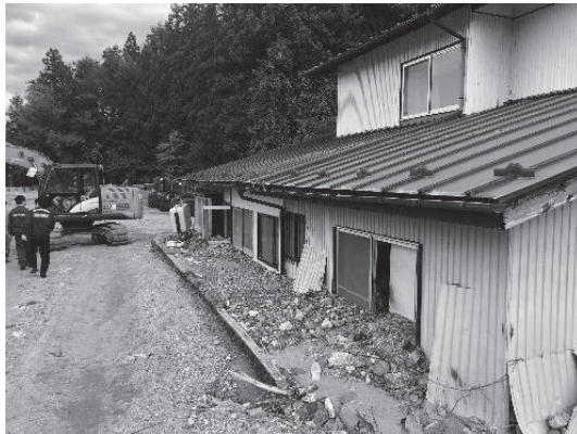
丸森町内の土砂堆積状況（1）
