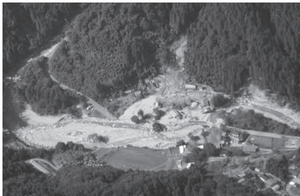
被災状況（ヘリ写真）（丸森町）
