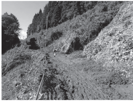
崩土による通行止め
