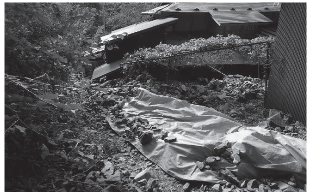
被災状況（登米市）
