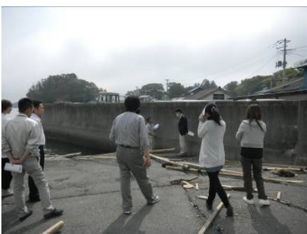
被害状況調査 (名籠漁港)
