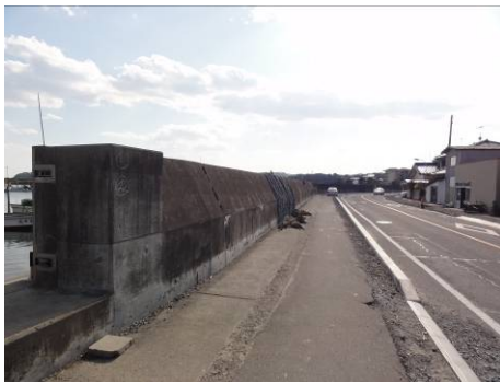
■ 磯崎漁港の防潮堤の景観
