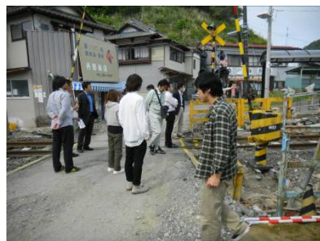
被害状況調査 (仙石線陸前富山駅周辺)
