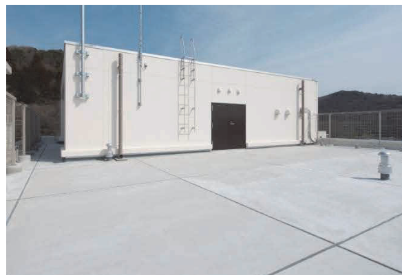
[写真：屋上へ一次避難スペースと隣接し、防災倉庫を設置]
