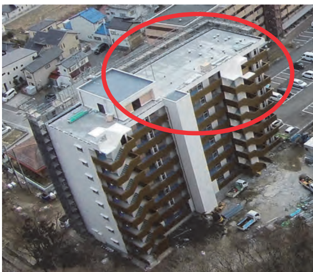
[写真：屋上へ一次避難スペースを確保]
