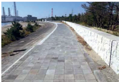
写真:復旧後の湊浜親水護岸外
