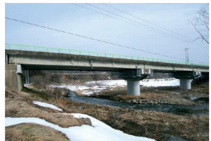
写真:耐震工事をを行った橋
