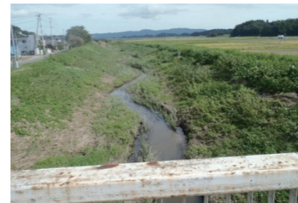
写真: 高倉川河道掘削工事着工前の様子(角田市)
