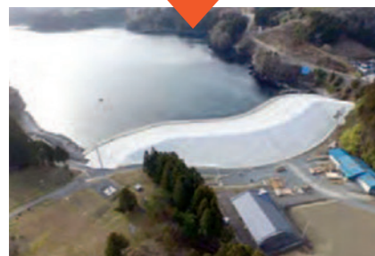
写真: 復旧工事完了後
