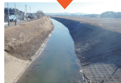
写真: 工事完了後
