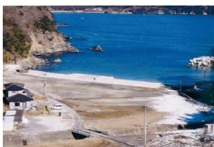
写真: 雄勝浪板地区海岸復旧工事(石巻市)
