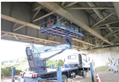
写真:橋梁点検現地研修(リフト車を使用した研修状況)
