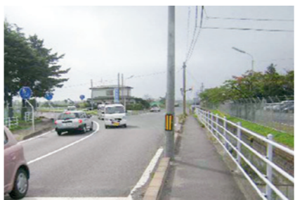
写真：石巻工業港矢本線の災害復旧工事
