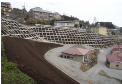
写真:法面(のりめん)保護工事
