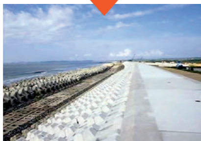
写真: 復旧工事完了後
