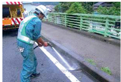
写真:路面排水柵の清掃の様子
