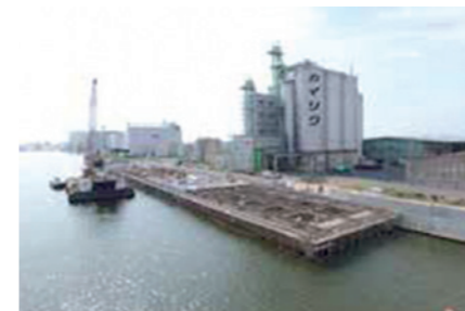
写真:新設の日和埠頭岸壁(仙台塩釜港石巻港区)
