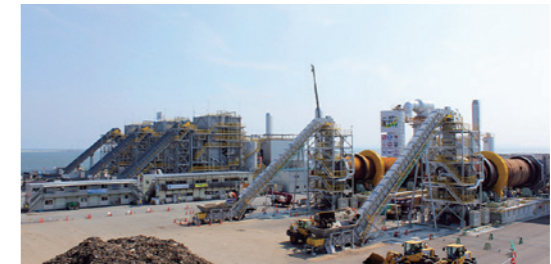
写真:災害廃棄物二次仮置き場(石巻市)
