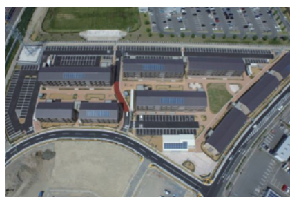
写真:災害公営住宅のソーラー発電(石巻市)
