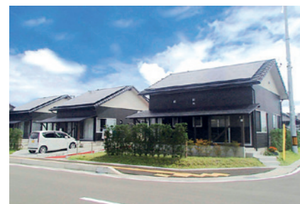
写真:完成した災害公営住宅(岩沼市玉浦地区)
