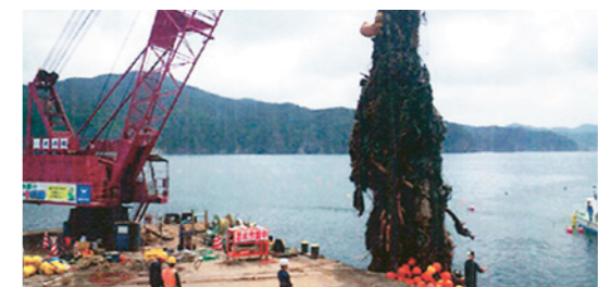
写真:海洋がれきの除去作業(気仙沼市)
