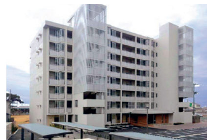
写真:完成した災害公営住宅(石巻市筒場地区)
