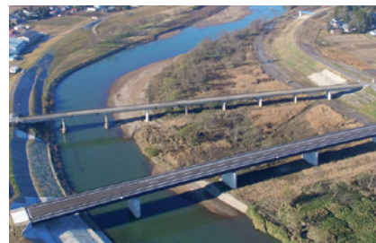
写真:新・志田橋(大崎市)
