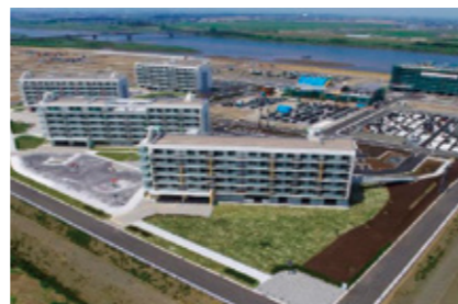
写真:関上中央第一団地(名取市)
