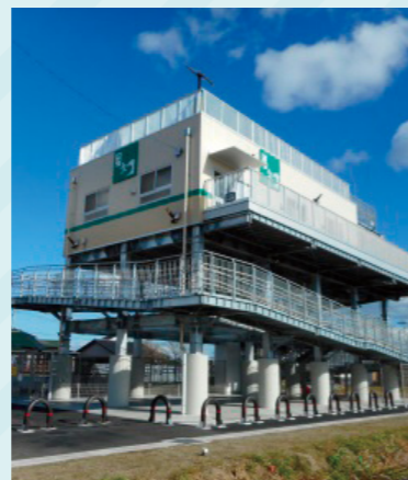
写真: 三本塚長屋敷津波避難タワー(仙台市)
