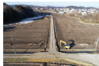
写真：ほ場整備の様子(松島町)
