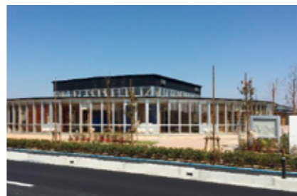
写真:山元町子育て拠点施設完成(山元町)
