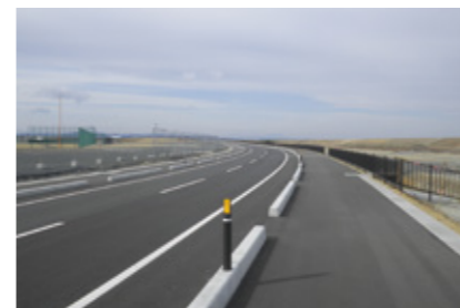
写真：津波避難道路荒浜大通線(亍理町)
