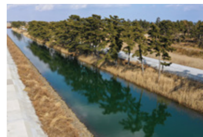
写真:五間堀川災害復旧工事完成
