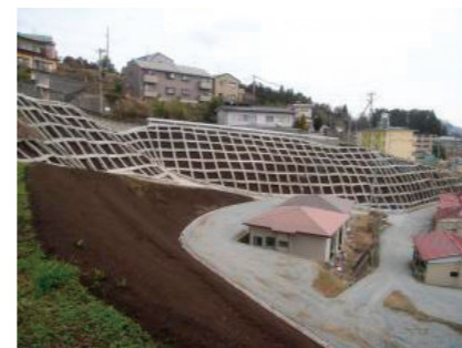
写真:急傾斜地崩壊対策事業 館山一丁目の3(気仙沼市)
