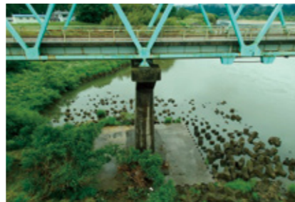
写真:県道亘理大河原川崎線 東根橋(耐震化前)
