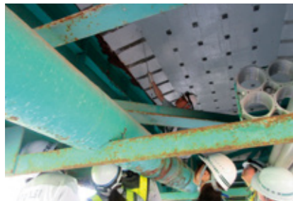
写真:宮城県道路メンテナンス会議 現場点検研修
