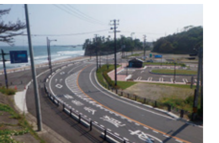
写真:主要地方道塩釜七ヶ浜多賀城線 菟浦田浜復興道路開通
