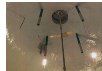
写真：塗装を施した汚泥浄化タンク(県南浄化センター)
