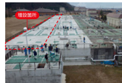
写真：増設した処理場施設(石巻浄化センター)
