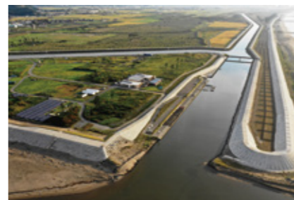
写真:北上運河災害復旧工事完成
