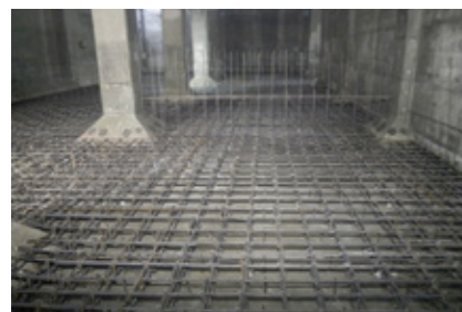
写真：麓山第一調整池耐震補強工事(施工状況)
