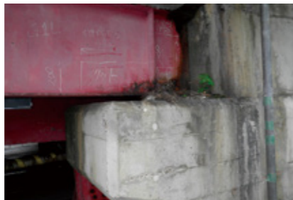
写真:国道286号 釜房大橋(補修前)
