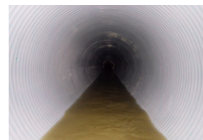
写真：内面を被覆した管路施設
