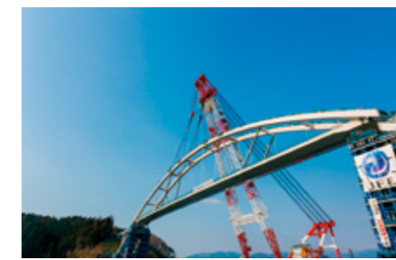
写真:一般県道大島浪板線 気仙沼大島大橋架設完了
