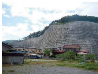
写真:急傾斜地崩壊対策事業 鹿妻(石巻市)
