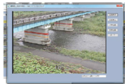
写真:河川監視カメラ画像 白石川
