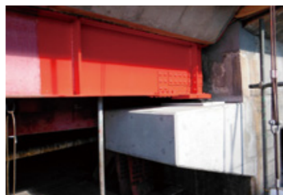
写真:国道286号 釜房大橋(補修後)
