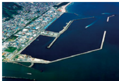
写真: 石巻漁港の復旧状況
