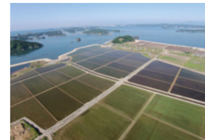
写真:奥松島地区 区画整理工事完了後の営農再開状況
