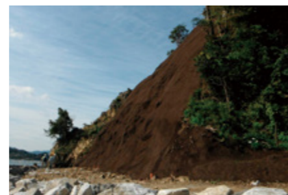
写真：三陸リアスの森保全対策事業(気仙沼市鮎立)
