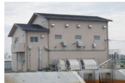
写真:大曲第二排水機場(東松島市)
