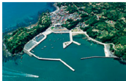
写真: 仁斗田漁港の復旧状況
