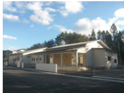
写真:小島・大浜地区の高台に移転した石巻市雄勝保育所(石巻市提供)
