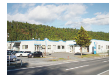
写真:復旧した工場の写真(気仙沼市)
