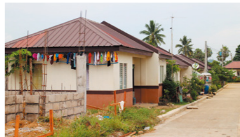
2013年、台風ヨランダにより大きな被害のあったフィリピン。NGOの支援で建設したレイテ島の中心都市タクロバンの住宅。日本ではあまりない事例だが、世界ではNGOによる住宅建設の支援が多い。
