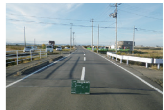
ゆぐんだガードレールや縁石を整備した道路。
