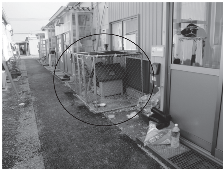
図3 仮設住宅における飼養施設
