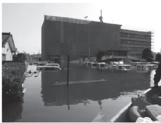
浸水した石巻合同庁舎（正面）
