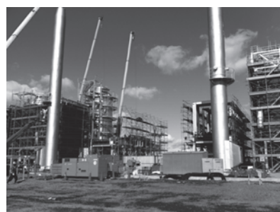
建設中の処理施設
