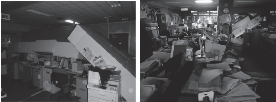
東部保健福祉事務所（2 階執務室）の状況（左：企画総務班 右：環境衛生部）
