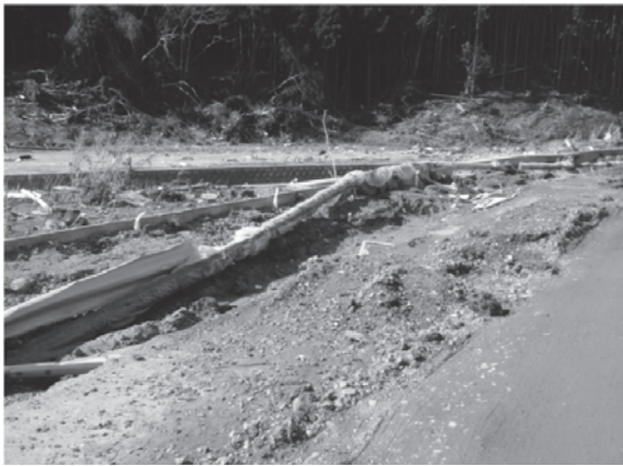
県道に埋設されていた配水管が、津波により露出している状況
