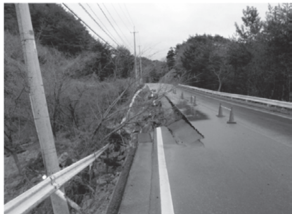
配水管の埋設されている県道の状況(万石橋添架管の破断により送水できないため、配水管の被害を確認できない状況)
