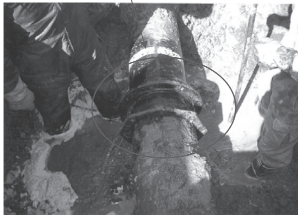
配水管からの漏水状況
