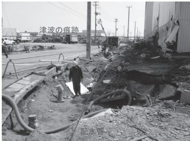
歩道内に埋設されている配水管の復旧作業
