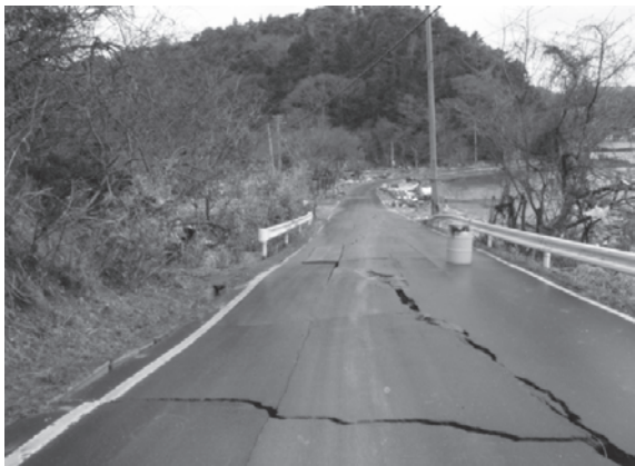
配水管の埋設されている県道の状況(万石橋添架管の破断により送水できないため、配水管の被害を確認できない状況)
