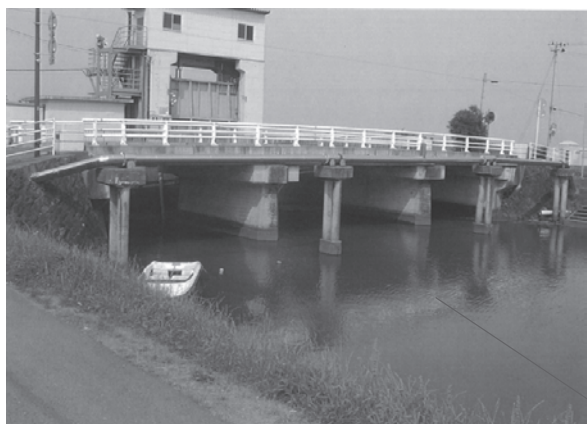
沿岸部 水管橋の津波による被害(被災前)
