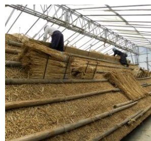
茅葺屋根の葺替え
