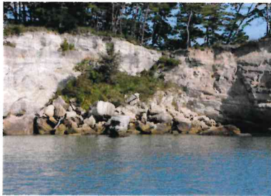
海食崖の崩落
