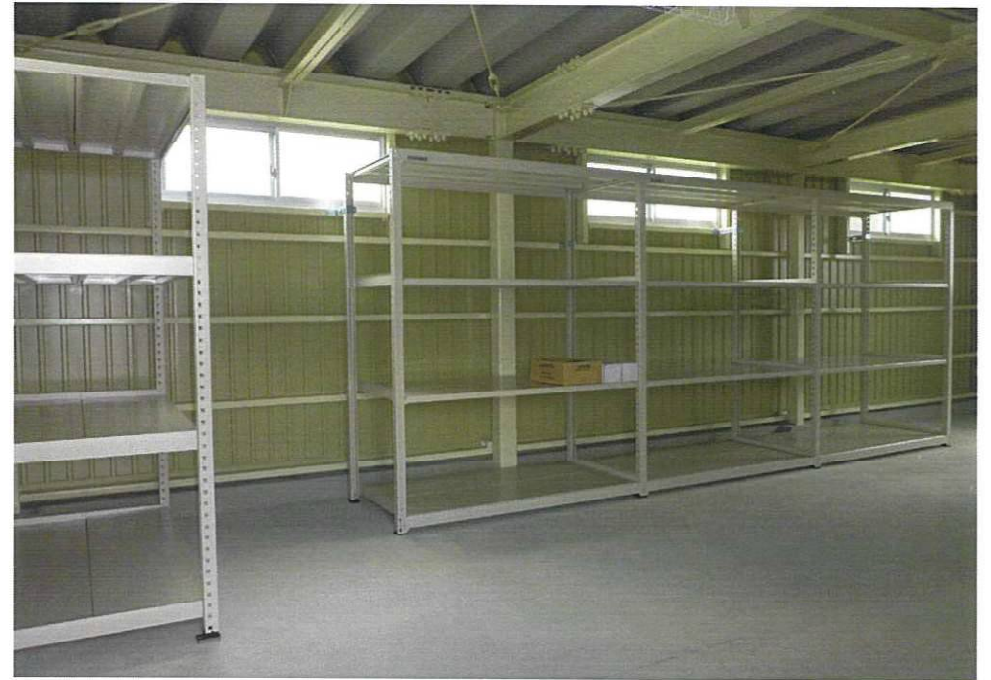
建物内部南面
