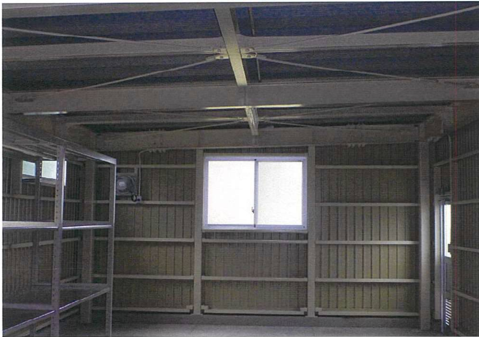
建物内部東面
