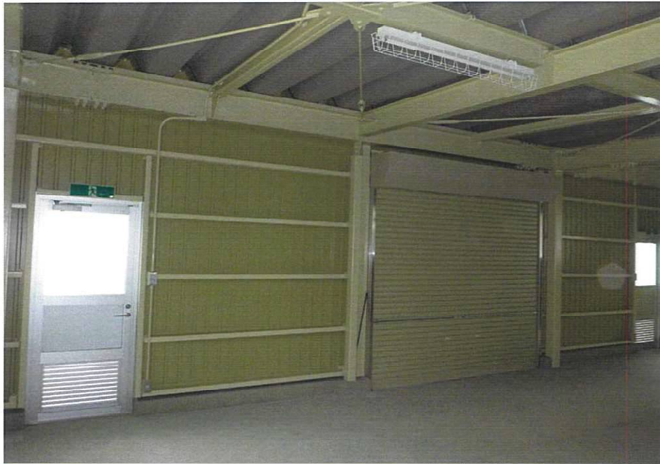
建物内部北面
