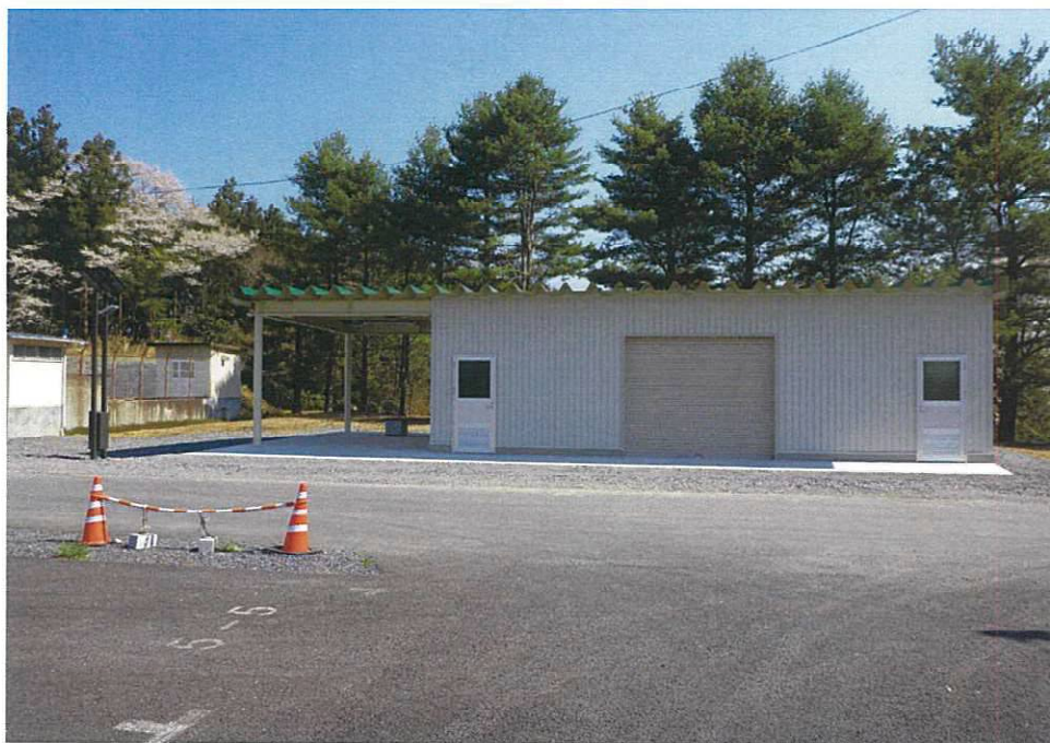
建物外部北面
