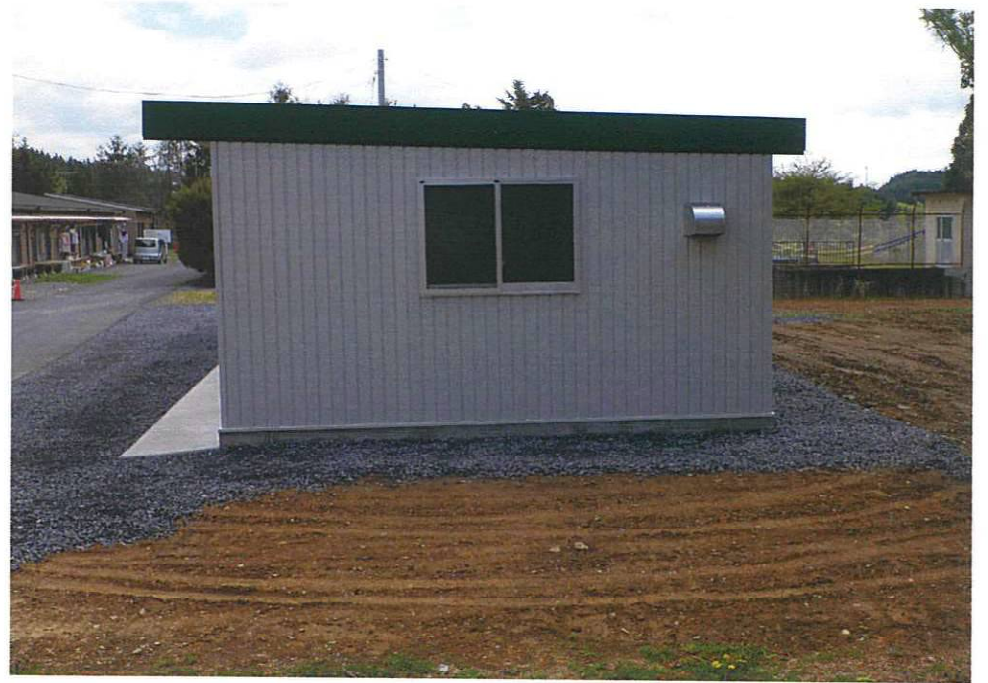
建物外部西面
