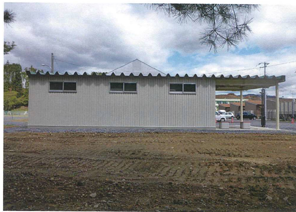
建物外部南面
