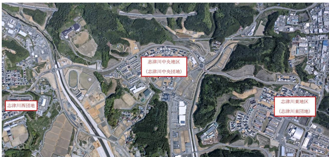
復興拠点連絡道路空撮（志津川西団地、志津川中央団地、志津川東団地を結ぶ路線）
