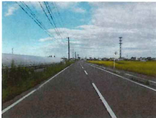
完成①（起点部）
