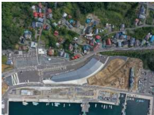
<建築工事完了後>
