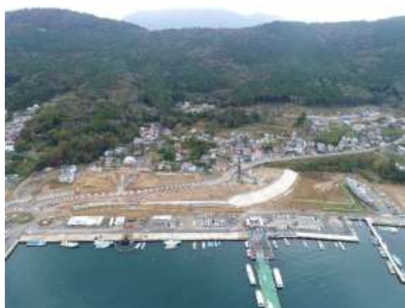
<造成工事暫定完了後 (建築着手)>
