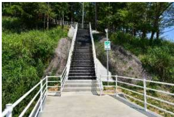
<整備後（大谷川浜地区避難路）>
