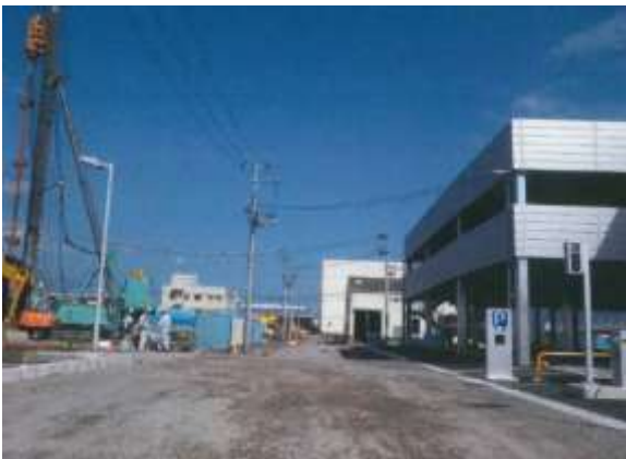
＜避難通路・整備前＞
