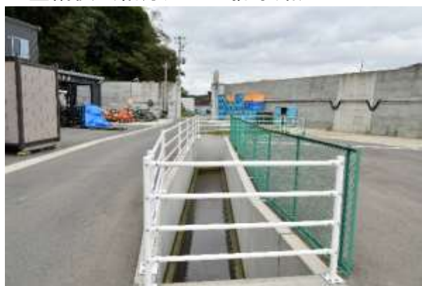
<整備後（給分浜地区排水路）>
