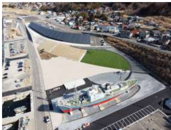
<全工事完了後>
