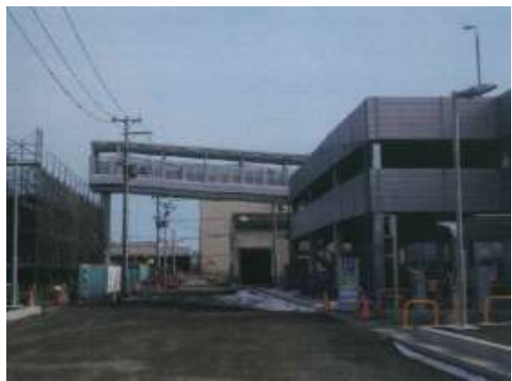
＜避難通路・整備後＞
