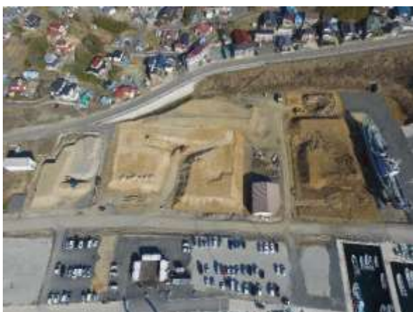
<造成工事着手前>
